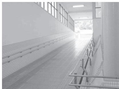
福市地下道出口付近 スリップ・転倒注意 スロープ傾斜 上り約 8 度 スロープ長さ 上り約 40 m 出口を左折
